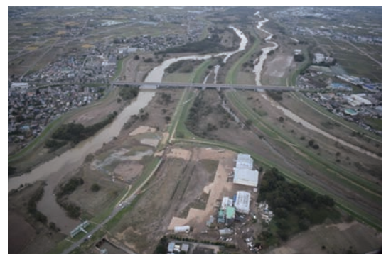
2019年台風19号による 越辺川堤防の被害
