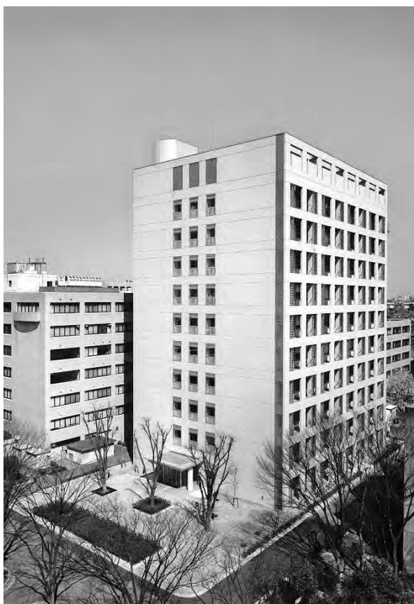
【写真 15-1】 総合研究棟
