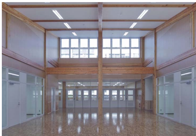
教育学部 D 棟: 柱(県産杉材)・梁(米松)の構造材に 大断面の集成材を用いた木造建築
