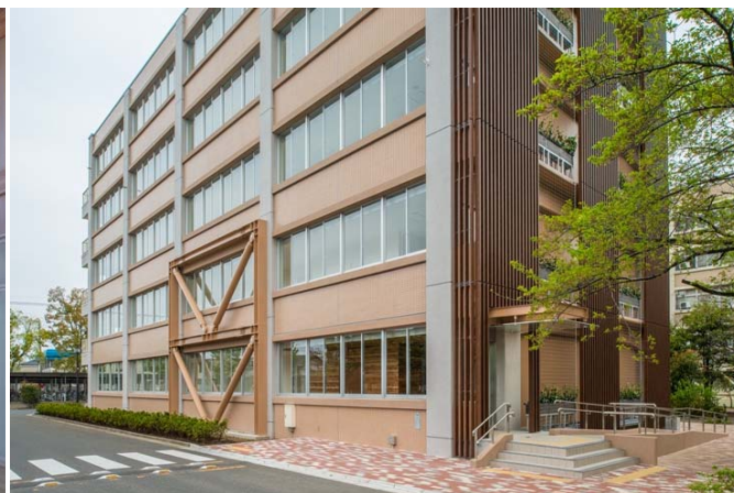
耐震改修を行った全学講義棟 2 号館: 外観
