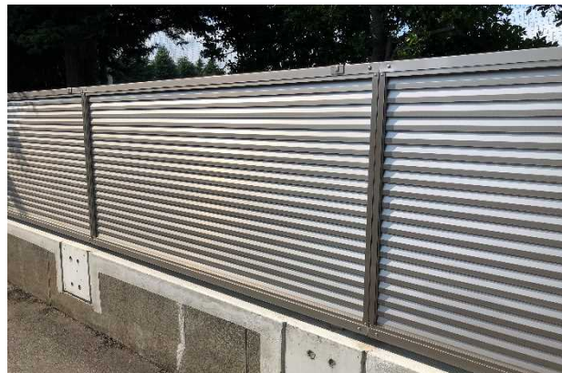
新設したアルミフェンス(教育学部附属中学校)
