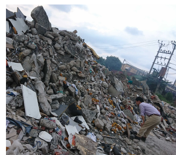
建設廃棄物の有害物質調査 (ベトナム)
