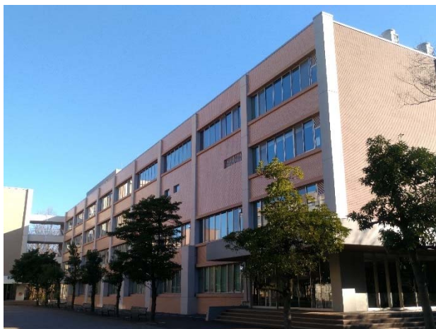
改修された全学講義棟1号館
