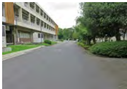
⑥歩車道未整備（現状）
