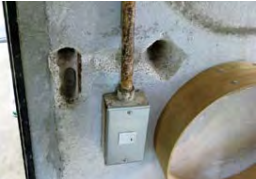
点検部位（コンセント）
