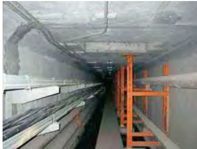
理学部 1 号館南側共同溝
