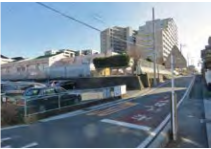
⑤ 敷地北西より北側外観を望む
