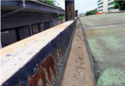
点検部位（屋上防水）
