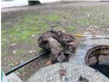
排水桝から取り出した木の根
