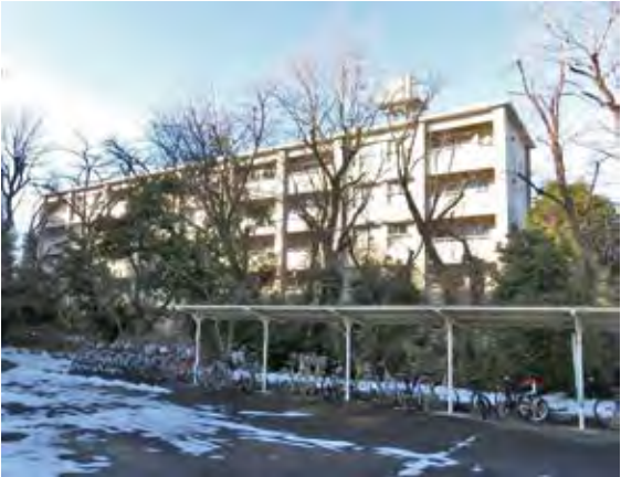
⑥インターナショナルレジデンスに改修予定の大久保宿舍南側の緑地は樹木過密に植栽されており雑然としている。
