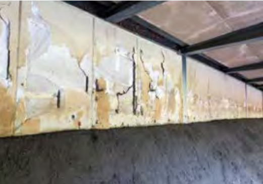
点検部位（的場壁面）
