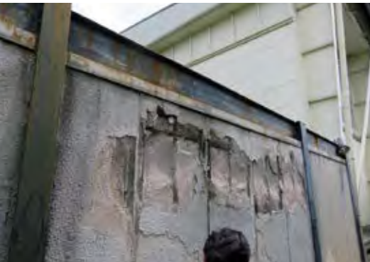
点検部位（外壁）
