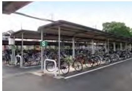
②構内駐輪場
