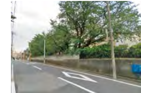
③ 北側道路より境界ブロック壁等を撮影
