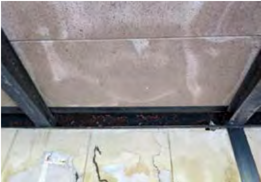
点検部位（的場天井 ALC 面）
