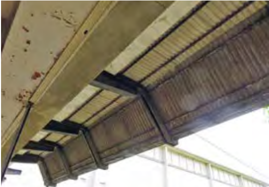
点検部位（庇・軒）
