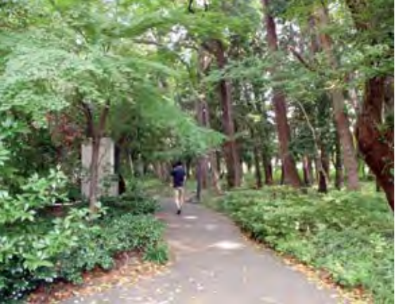
③歩道にせり出している枝葉（通行に支障）
