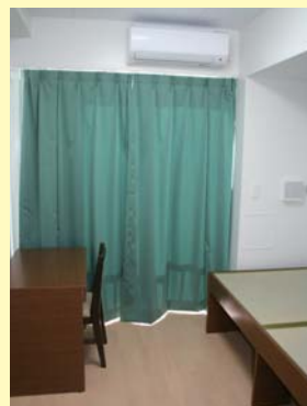
エアコン・机・椅子・ベッド
