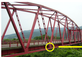
研究対象の鋼トラス橋（供用年数43年）
