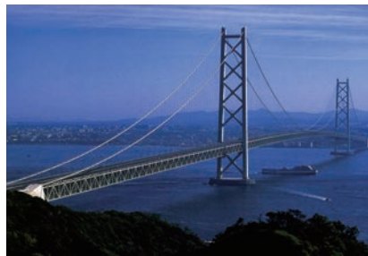
1998 開通の明石海峡大橋(本州四国連絡橋公団提供)
