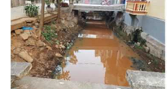
生活排水路に流出した汚泥（ベトナム）
