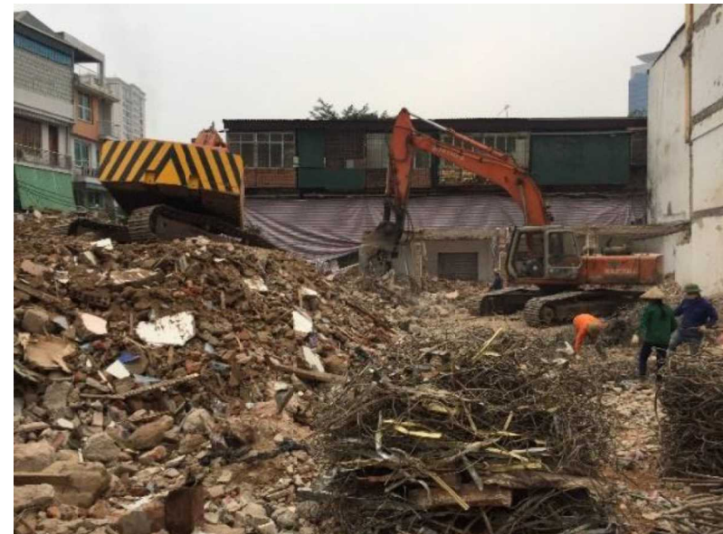
再開発にともなう建設廃棄物の排出 (ベトナムハノイ市)
