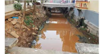
生活排水路に流出した汚泥（ベトナム）
