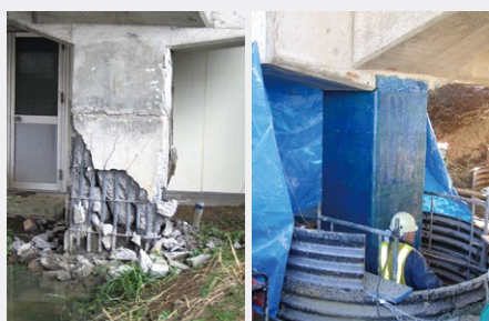
新潟県中越地震により損傷した新幹線高架橋(左)は迅速な復旧により回復した(右)
