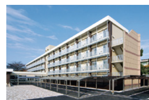
学生宿舎1号館
