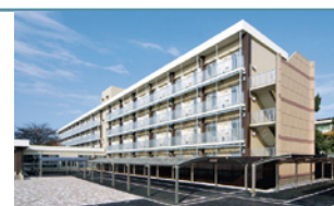
学生宿舎1号館
