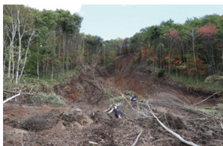
土砂災害(斜面崩壊)の調査
