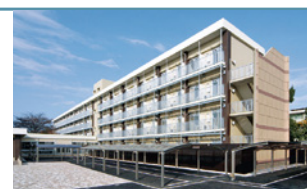
学生宿舎1号館
