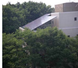
大学会館屋上のソーラーパネル
