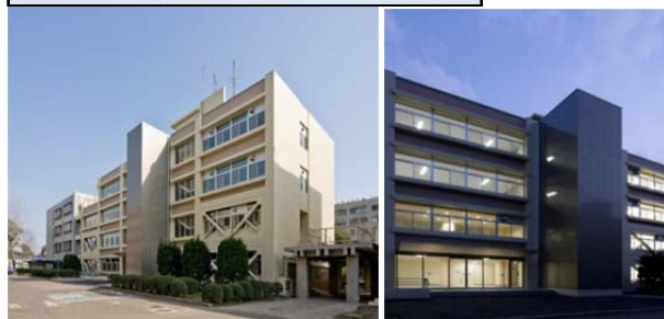
耐震改修工事を行った工学部講義棟
