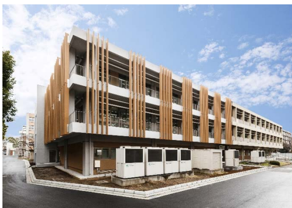
改修された図書館(2号館)
