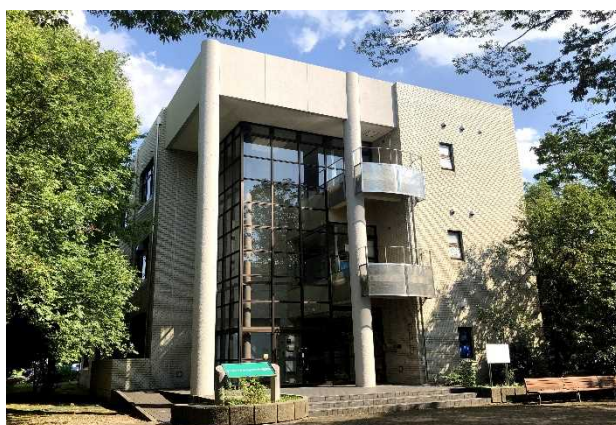
外壁改修を行ったオープンイノベーションセンター研究棟
