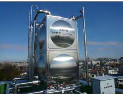
ステンレス製の水槽
