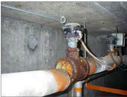
腐食による給水管断裂状況
