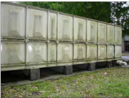
老朽化したFRP製の水槽
