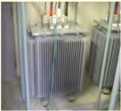
電気電子システム1号館 電気室内変圧器 (トッランナー型変圧器)
