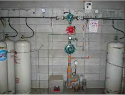
ボンベ庫内の圧力調整器
