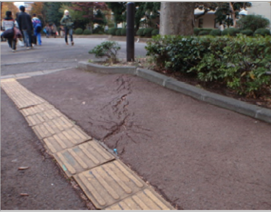
④樹根の成長により歩道が隆起している。
