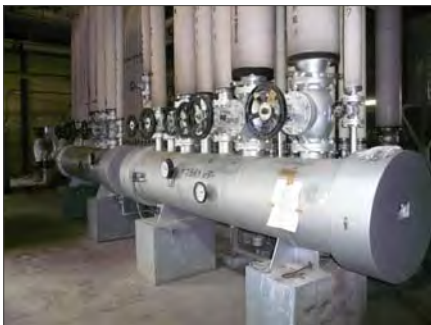
老朽化したボイラ付帯設備
