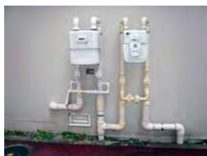
ガスメーター
