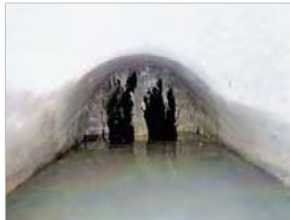
木の根による管路の閉塞状況 2
