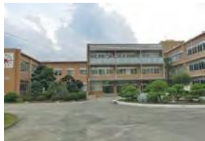
① 校舎エントランス
