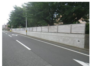
③ 安全対策によりブロック塀からアルミフェンスに改修された北側道路境界部分
