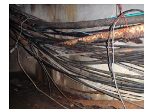
建物ビット内湿気による電気配線管腐食状況など
