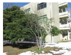
⑤樹木の立ち枯れや枝折れしている状況
