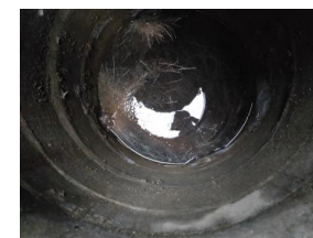
既存樹木根の侵入による排水管の詰まり
