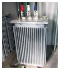
応用化学科棟2号館 電気室内変圧器 (トップランナー型変圧器)
