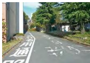
④歩車分離による白線引き状況
