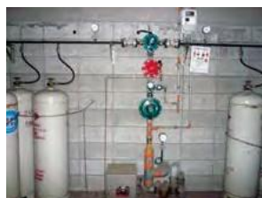
ボンベ庫内の圧力調整器
