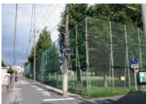
④ 敷地北西道路より運動場を望む
