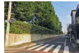
⑤ 西側敷地の境界部分における高低差の状況
