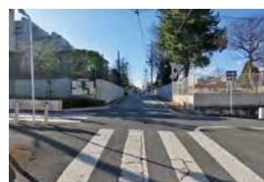
④ 園舎離れ敷地東より正門道路部分を写す
