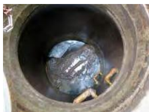
侵入した木の根で閉塞状態の排水樹内
