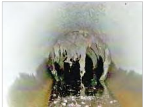
木の根による管路の閉塞状況 1
