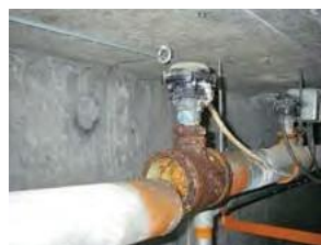
腐食による給水管断裂状況
