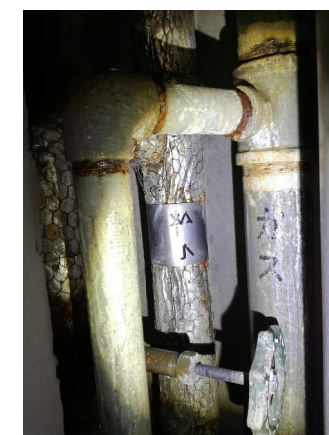
経年によるガス管継ぎ手部分の腐食など
