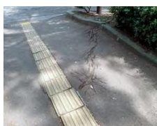
④樹根の成長により歩道が隆起している。
