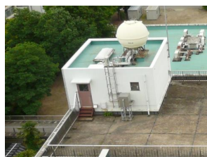
老朽化したFRP製の水槽
