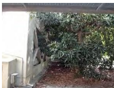
①建物に近接して樹木が植栽されている。
