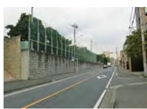
④ 南側道路に面する敷地境界の既存樹木の状況
