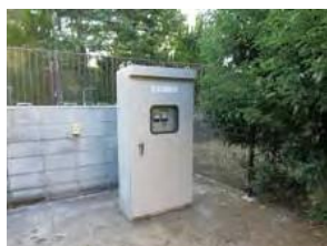
井戸用制御盤 (教育井戸)
