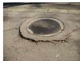
地盤沈下によるマンホール周辺舗装部分の陥没
