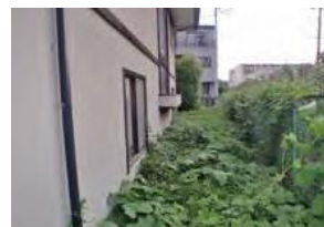
⑥ 南東から切敷川と境界フェンス部分を撮影
