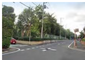
② 東南から小学校の建物群を望む
