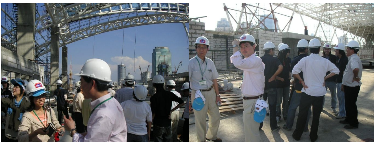
アドバンスインターンシップ（橋梁建築現場）
